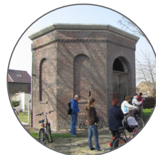
Un bâtiment de pompage
