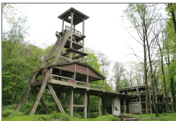
« Je suis une structure qui servait à descendre et remonter les mineurs dans la mine en utilisant des câbles. Je suis entièrement construit en béton. »
